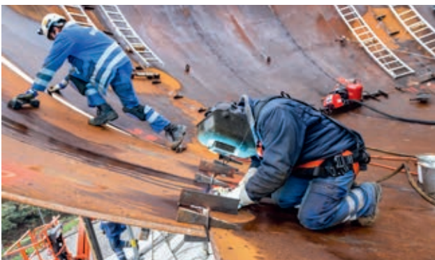
Mitarbeitende von Bilfinger beim Zusammenfügen und Schweißen der unteren Halbkugel.
