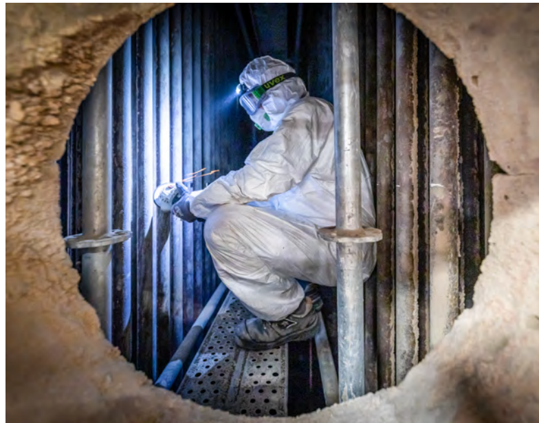
Restmasskontrolle am Überhitzer
