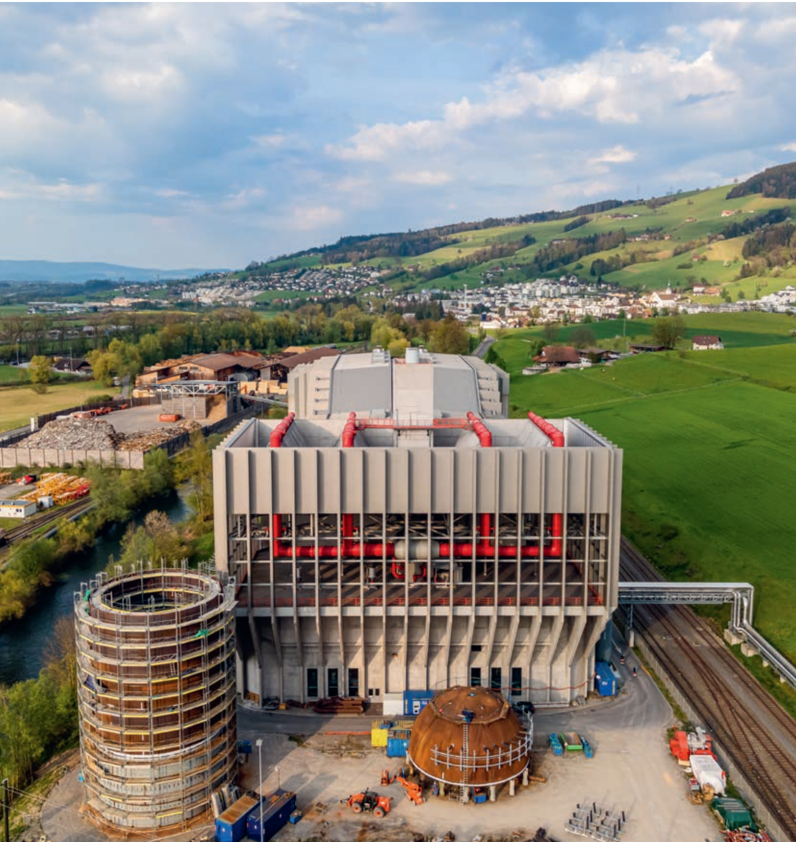
Die Baustelle des Heisswasserdruckspeichers und der LUKO aus der Vogelperspektive.
