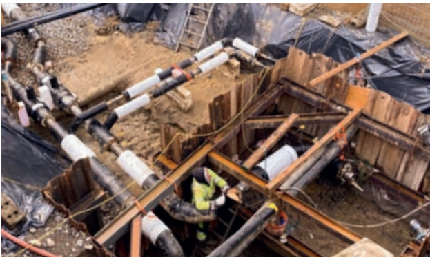
Bau Fernwärmeleitung WWZ in Rotkreuz.
