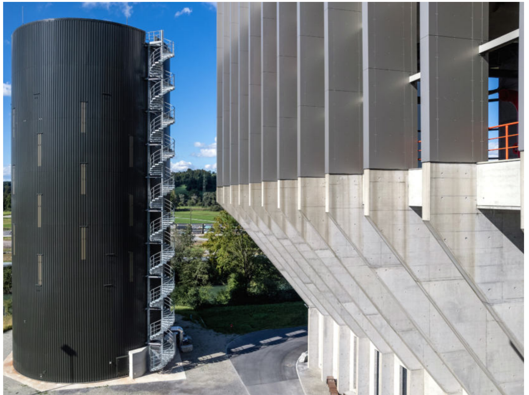
Blick auf den Heisswasserdruckspeicher und den LUKO.
