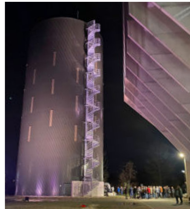
Einweihungsfeier Heisswasserdruckspeicher 24. November 2022.
