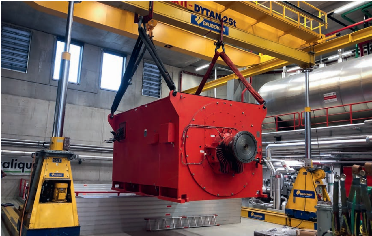
Montage des neuen Generators
